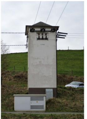
Turmstation der 1950er Jahre aus Fertigteilelementen und moderne Kompaktstation (orne)
